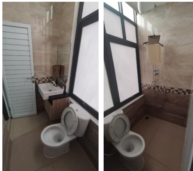
Gambar 49. Renovasi toilet gedung Batik It 3,4, dan 5
