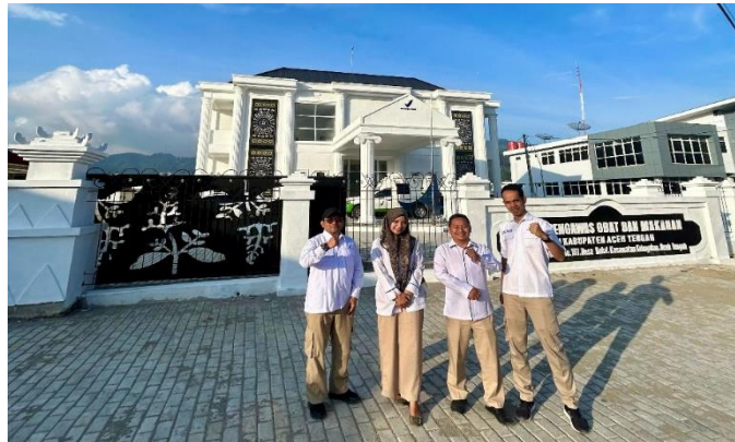
Gambar 81. Pendampingan Pembangunan Balai POM di Aceh Tengah
