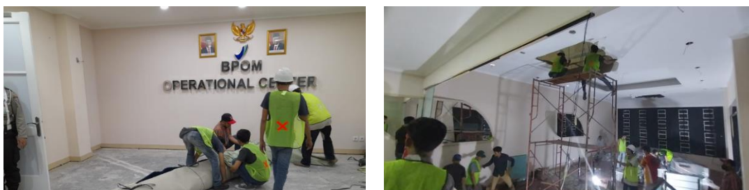
Gambar 63. Proses pembangunan ruang BCC
