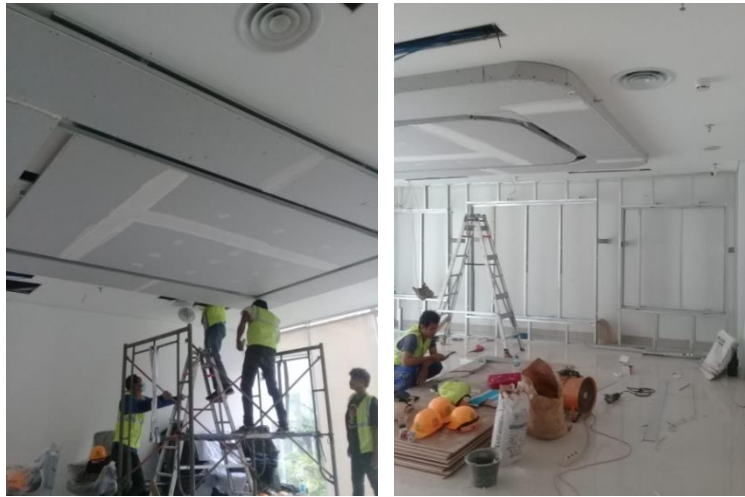
Gambar 61. Ruang diorama saat proses pekerjaan
