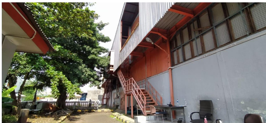
Gambar 46. Bangunan Gudang JIEP Pulo Gadung
