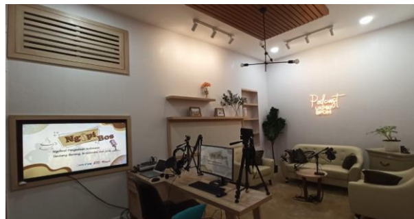
Gambar 50. Renovasi ruang podcast UKPBJ Lt.3
