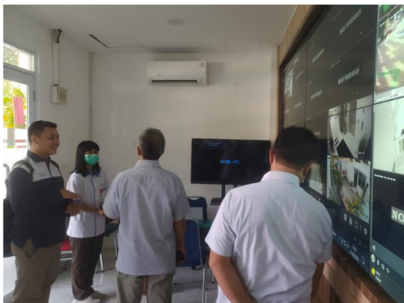
Gambar 58. Sistem PLTS dapat dilihat pada ruang kontrol CCTV gedung Athena
